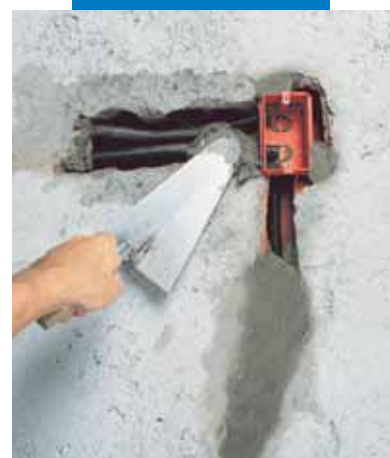
Fijación de cajas y conducciones eléctricas con Lampocem
