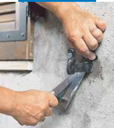
Colocación de grapas para ventanas con Lampocem
