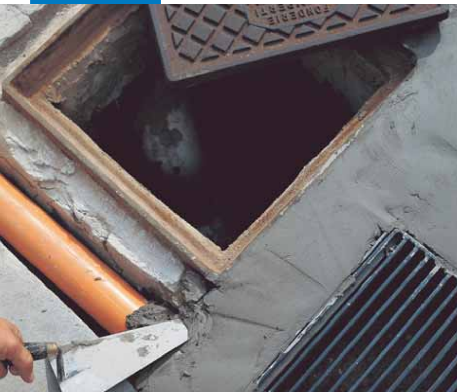
Colocación de cañerías y tapas de alcantarilla con Lampocem
