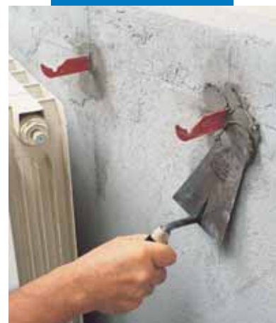
Colocación de garras para radiadores con Lampocem
